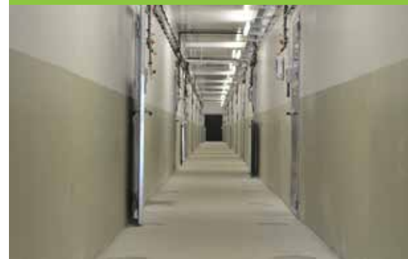
Zentralgang mit Schutzanstrich (optional)
