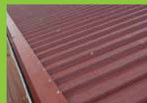
Variante 2: Stahltrapezblech
