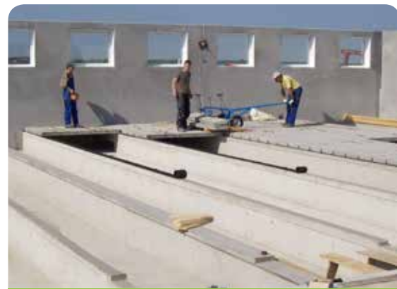
Lieferung und Verlegung der Betonspalten
