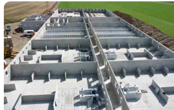
Massive Abteiltrenn- und Gangwände
