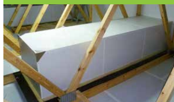
Lüftungskanalim Dachraum
