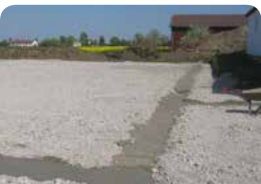
Fundamente unter den Aussenwänden
