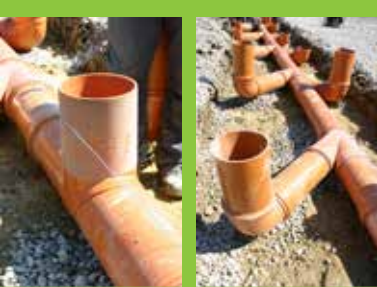
Gülleleitung: Frog- oder Abzweigsystem
