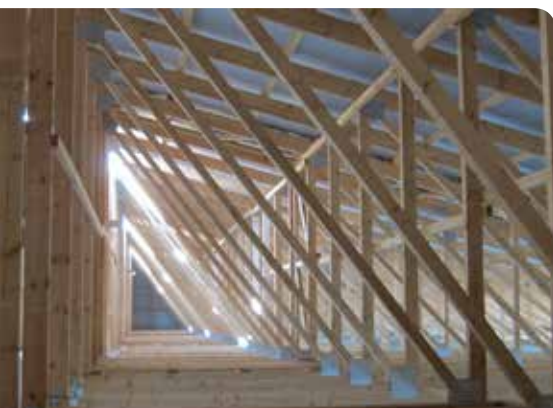
Nagelplattenbinder als Dachkonstruktion
