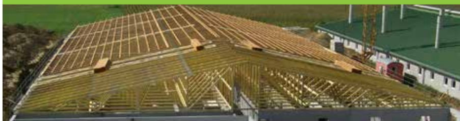
Dachkonstruktion mit Pultdachbindern als Satteldach
