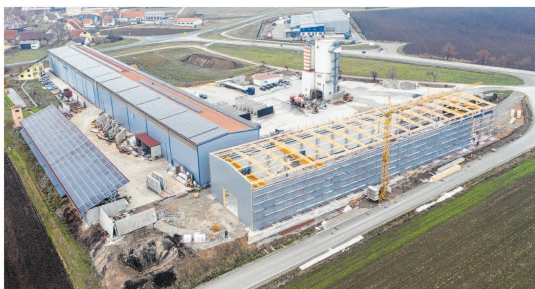
Neben dem Fertigteilwerk in Insingens entsteht gerade eine neue Halle mit über 2000 Quadratmeter speziell für die Vormontage der Wohnmodule samt Innenausbau.
