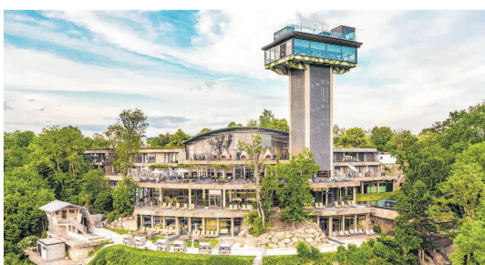
Das Mawell Resort in Langenburg ist bundesweit einzigartig und das nicht nur baulich. Das Wellness-Spa mit Angeboten wie Event-Sauna und Infinity-Pool bietet naturnahe Erholung.
